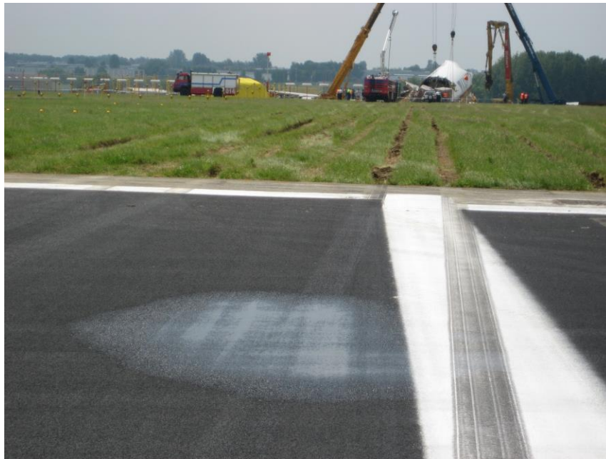
Déviation du décollage Kalitta interrompu sans zone RESA sur la piste 19
